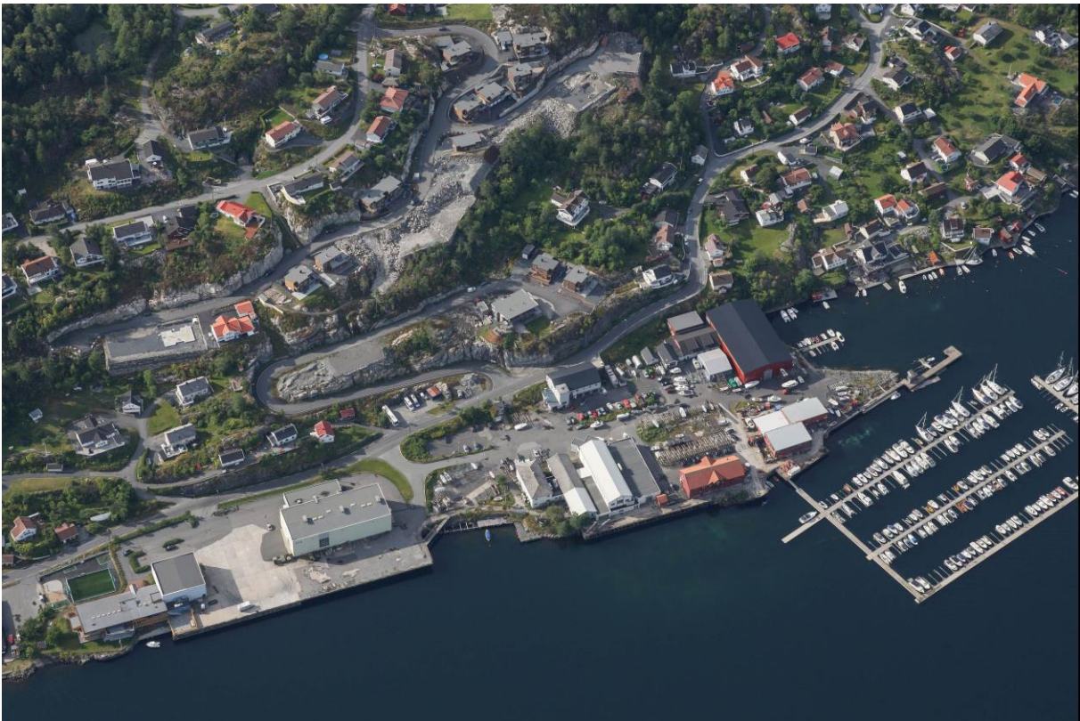
Figur 5 Skråfoto av dagens situasjon. Krana sett fra nord
