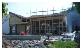
Risørhuset har i hele 2013 vært gjennom en ombygging.
