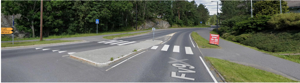
Figur 9 Fortau med kryssing i plan ved rundkjøring like ved skoleområdet.
