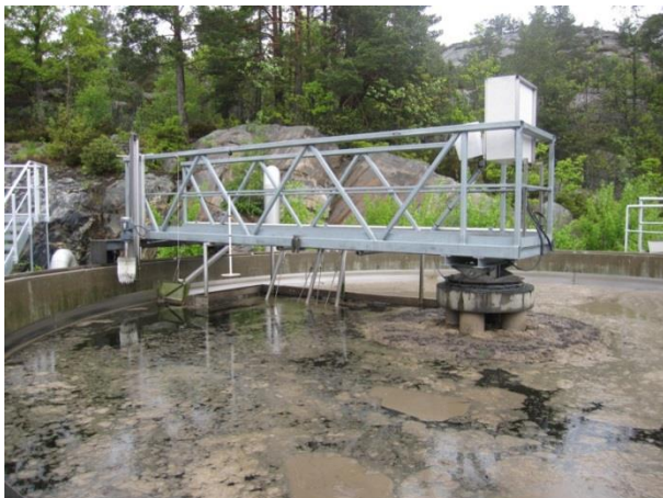
Figur 8 Slamskraper i sedimenteringsbasseng
