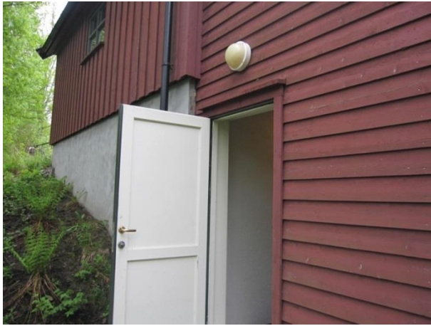
Figur 13 Detalj av tilstanden på panelet
