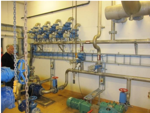
Figur 9 Slampumper (Ny Pumpe til venstre)
