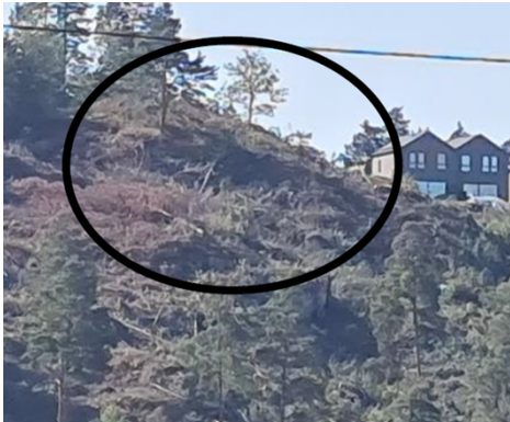
Kollen som det var ønskelig å sprengne ned og hente ut ca. 13.500 m 3 masser
